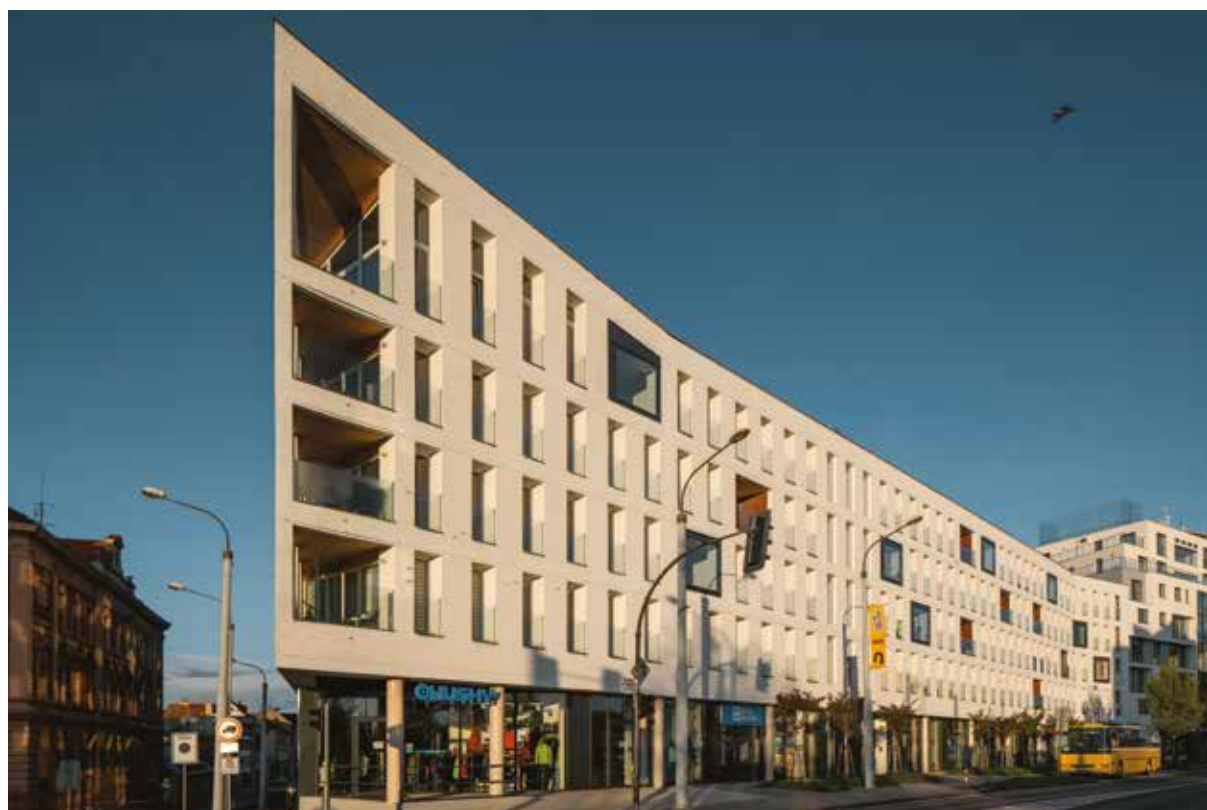
Plzeň se ohlédlá za současnou architekturou města a udělila Cenu Hanuše Zápala za období 2018–2021. Získal ji ateliér architekta Jiřího Zábrana za návrh bytového domu Otýlie Beníškové 20 v Plzni na Roudné (na snímku). O cenu usilovalo 15 staveb. Odborná porota se rozhodla udělit dvě mimořádná ocenění. Cenu poroty obdržel kolektiv ateliéru Projectstudio8 hned za dvě stavby – Družinu Újezd a Palubu Hamburk.
